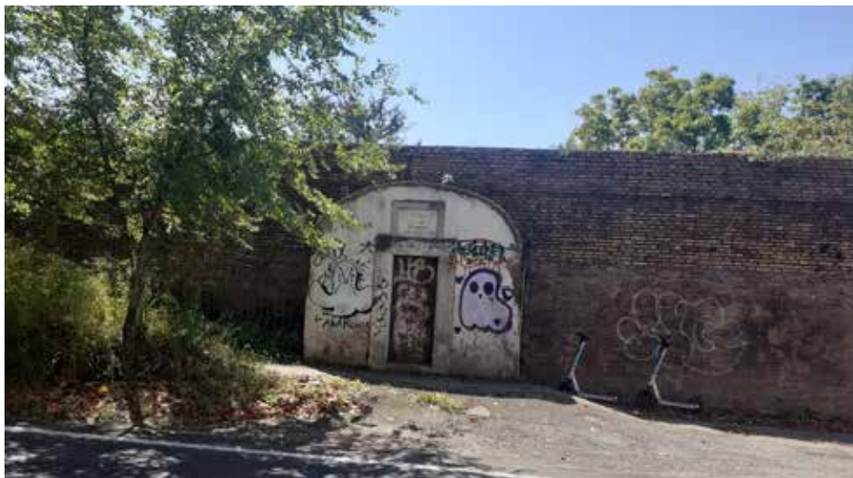
Acquedotto Vergine. Idrometro.
