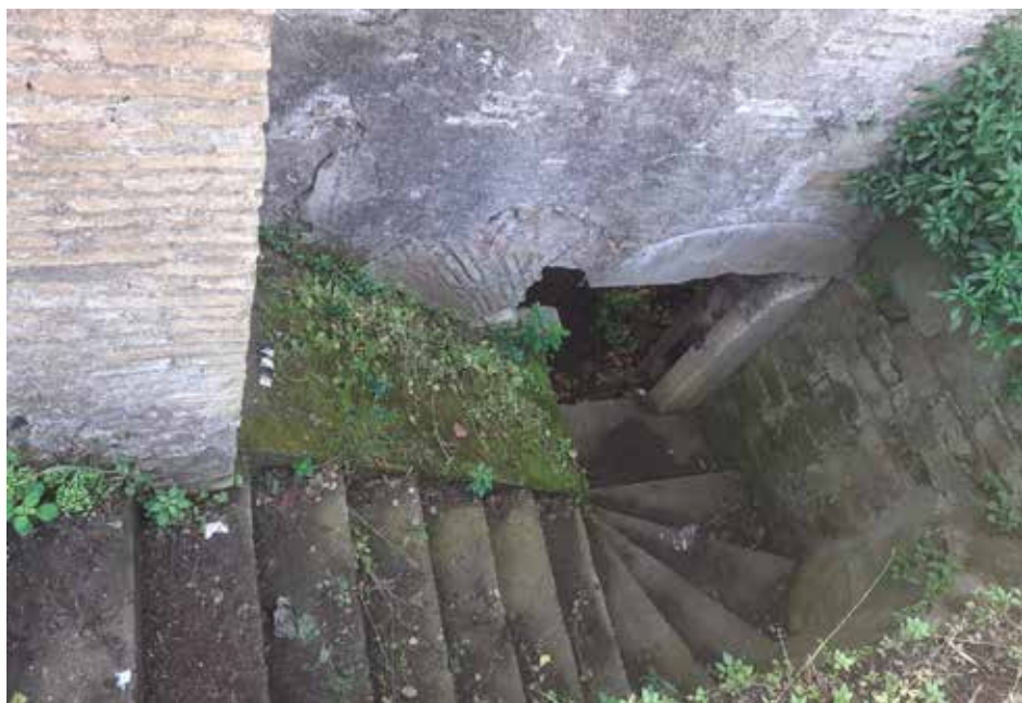
Acquedotto Vergine. Scaletta per il passaggio sul Fosso.
