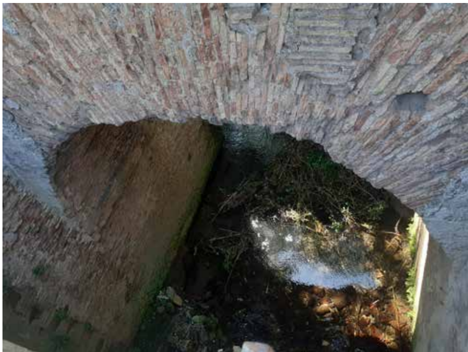
Acquedotto Vergine. Arcata sul Fosso della Marranella.
