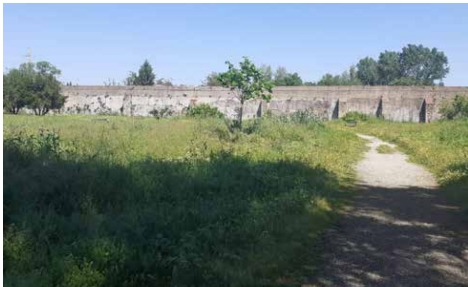
Acquedotto Vergine. Muro sud.
